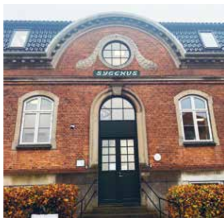
Hovedindgangen til Lægecenter Korsør. Foto: privat.
